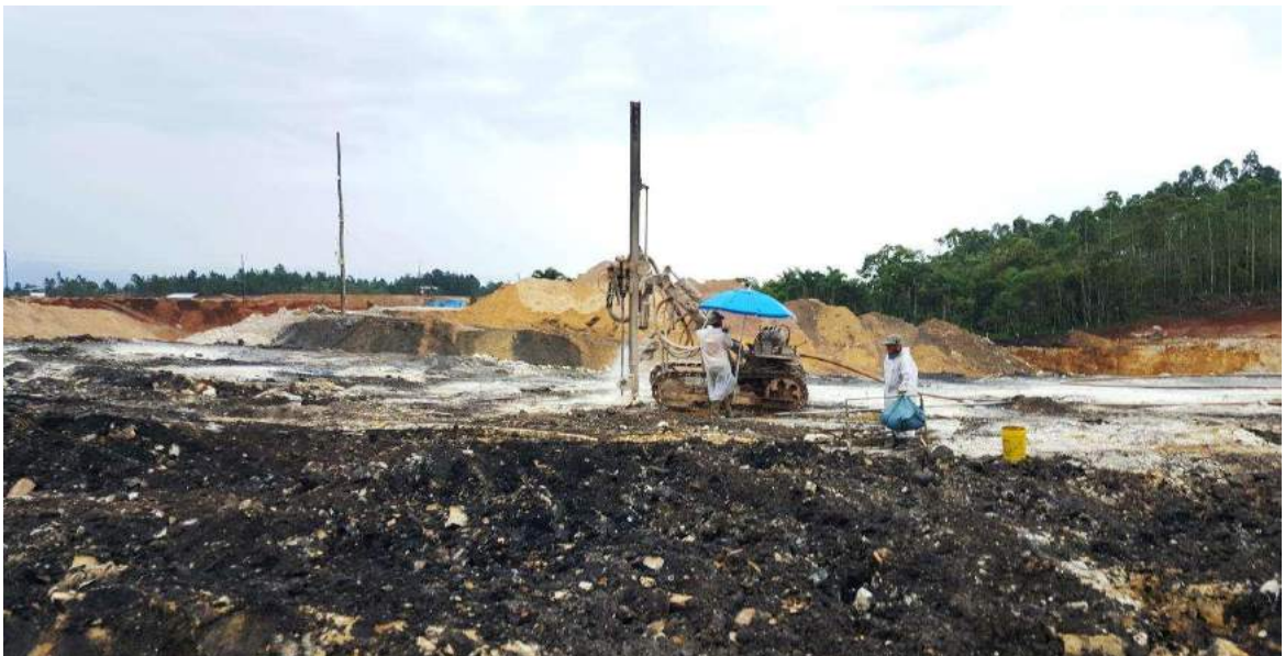
Figura 8: Perfuração do banco de arenitos de cobertura para desmonte com utilização de explosivos.
