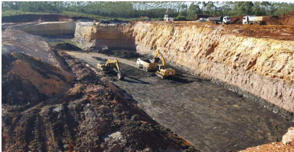
Figura 11: Desmonte mecânico e carregamento da camada de carvão em caminhões basculantes.
