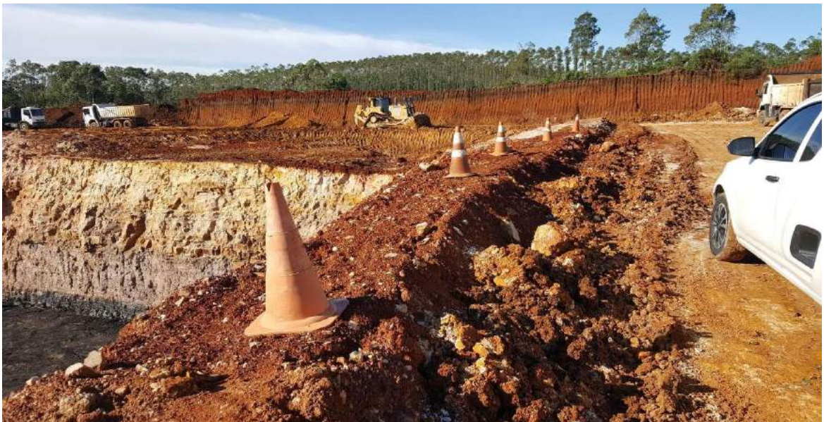
Figura 6: Remoção da camada argilo-arenosa de cobertura na Mina Santana Céu Aberto.
